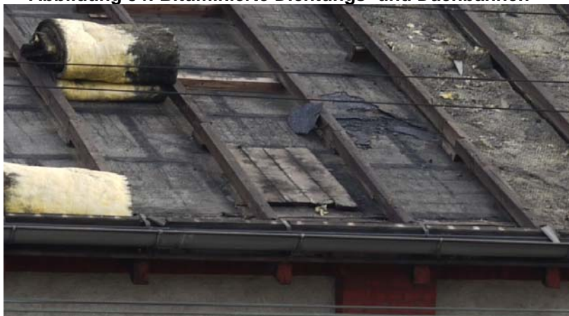
Abbildung 34: Bituminierte Dichtungs- und Dachbahnen
