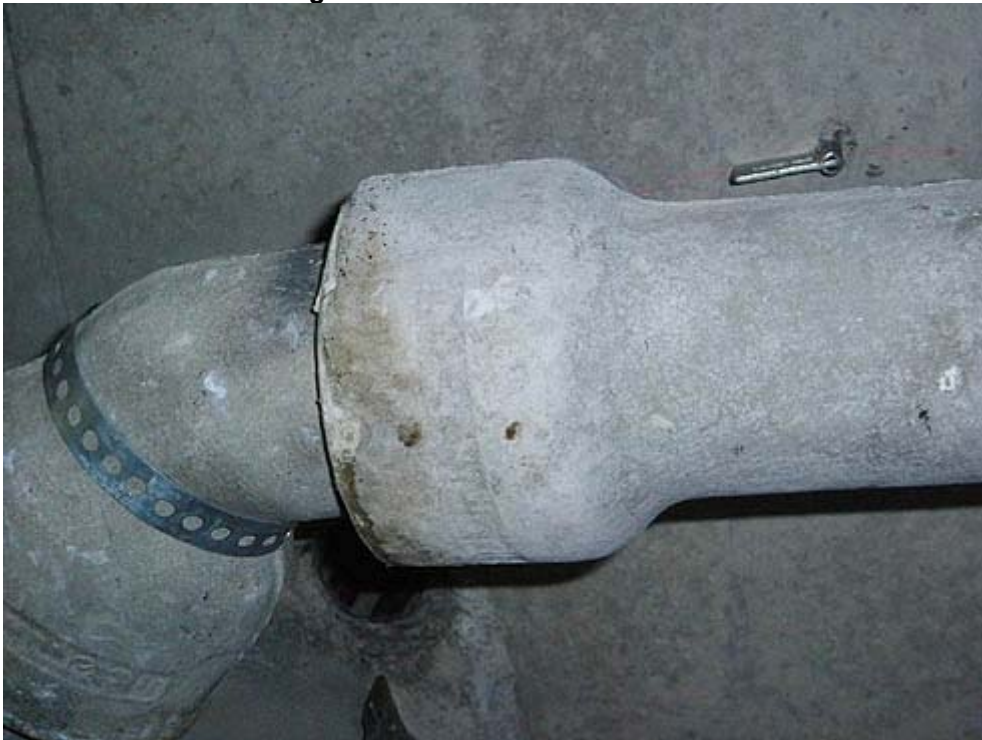
Abbildung 10: Abwasserrohr aus Asbestzement
