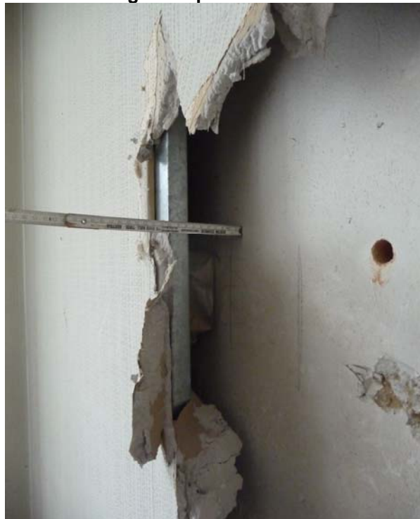
Abbildung 28: Gipskartonwandverbau
