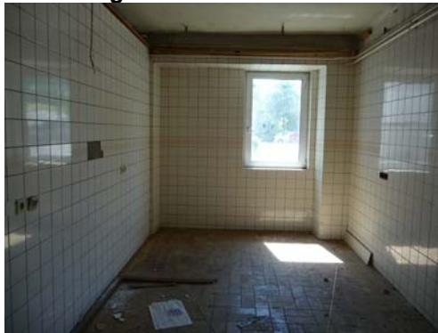
Abbildung 13: Wand- und Bodenfliesen
