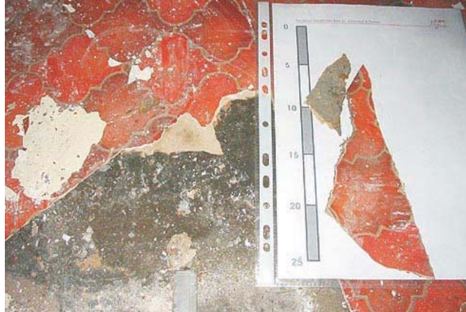
Abbildung 9: Asbesthaltige PVC-Rollwähre
