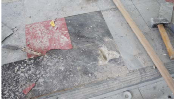
Abbildung 3: Asbesthaltiger Fußbodenbelag
