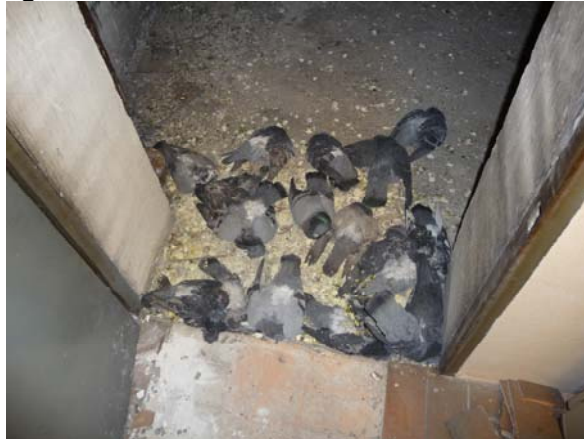
Abbildung 45: Taubenkotkontamination mit verendeten Tieren
