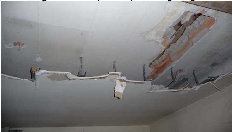
Abbildung 30: Mittels Gipskartonplatten abgehängte Decke
