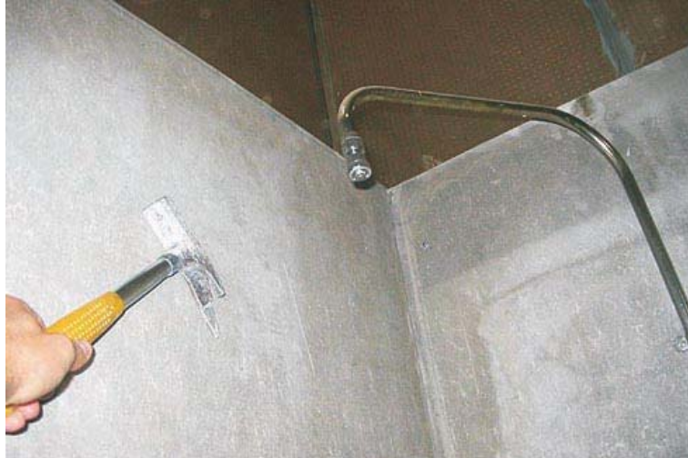
Abbildung 6: Asbestzementplatte
