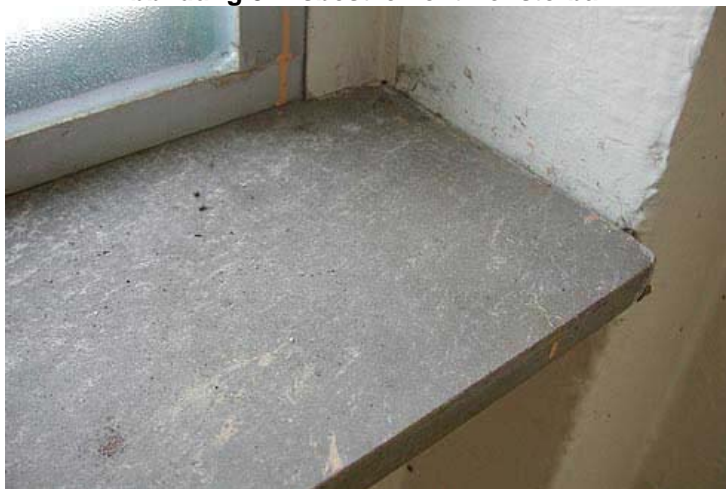
Abbildung 5: Asbestzement-Fensterbank
