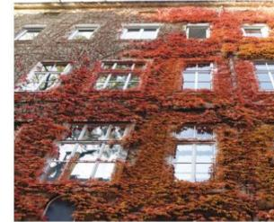
Der Typ eignet sich vor allem für Massivwände oder -konstruktionen, bei WDV5 ist die statische Eignung zu überprüfen und auf die Vermeidung von Wärmebrücken zu achten. Bei vorgehängt hinterlüftete Fassaden ist dieser Typ bedingt geeignet, soweit keine negativ phototrop wachsenden Pflanzen verwendet werden.)
